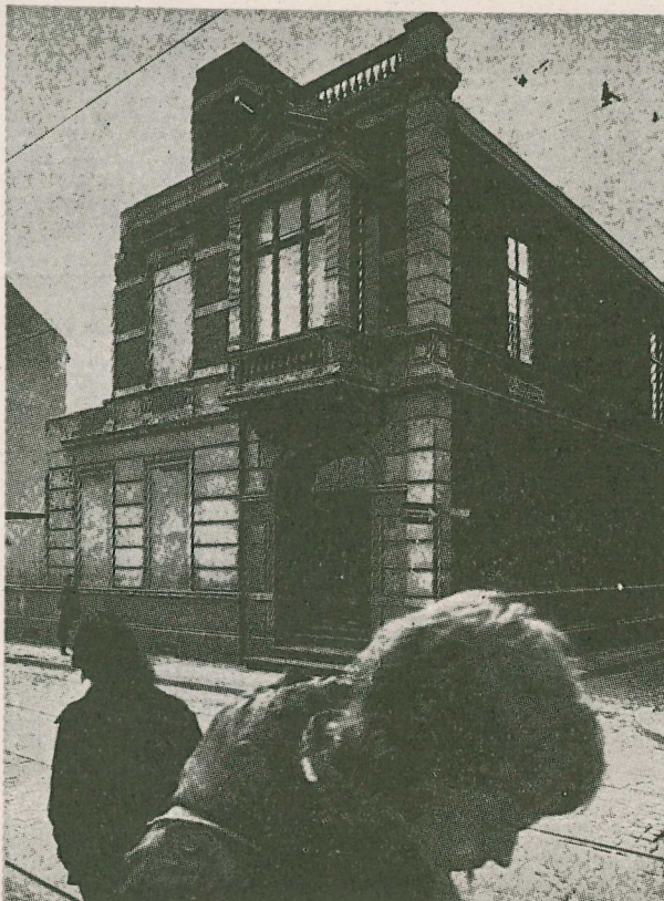
Dieses Haus an der Oberstraße — Ecke Rottelsgasse — wird Montag abgerissen.
