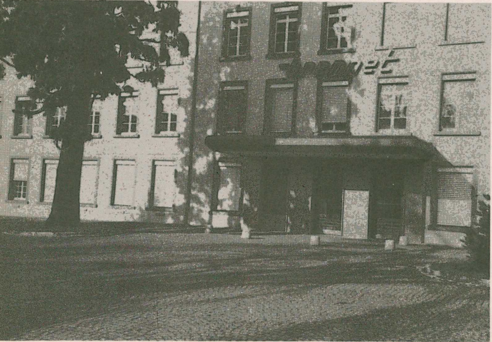
1985: Werk Brennet – Sanierung des Verwaltungsgebäudes
