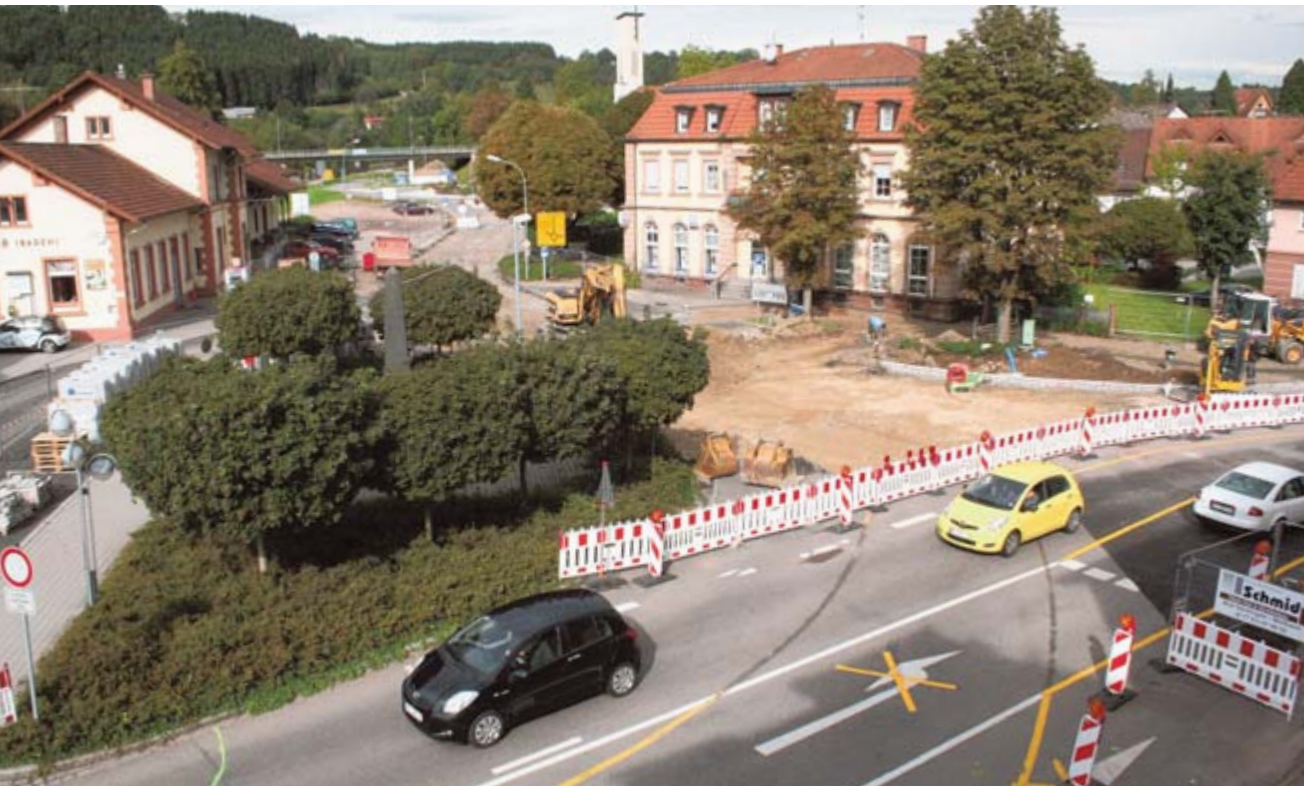
Derzeit ist die Zufahrt vom Bahnhofsplatz zum Kreisel an der Talstraße aufgrund der Baustelle für den Verkehr gesperrt. BILD: JASCH-RAMSTECK
