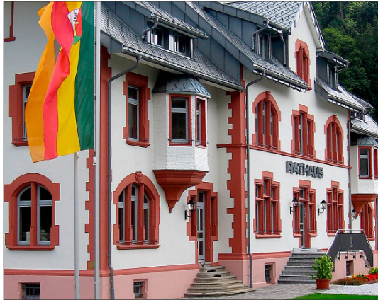
Schweres Gewicht des Sanierungsgebietes: das Rathaus
