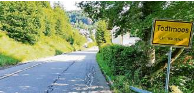
Die Schwarzenbacherstraße soll vom Orts-schild aus Richtung Klinik Wehrwald bis zur Einmündung in die Wehratalstraße als Tempo-30-Zone ausgewiesen werden. BILD: ANDREAS BÖHM
